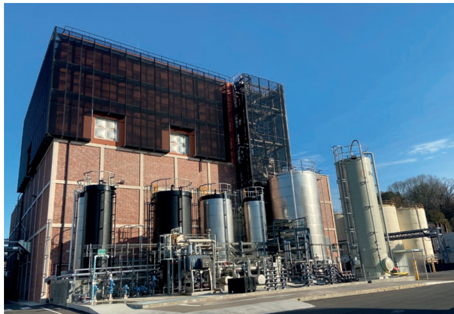
Usine Oléine de Dieppe (Seine-Maritime - 76)
