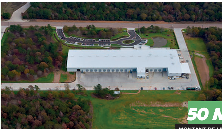
Nouvelle usine Oleon - Conroe (Texas, États-Unis)
