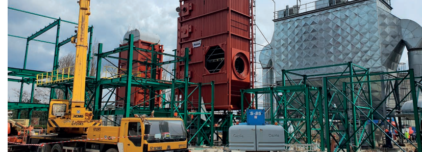
Construction de la nouvelle unité de cogénération sur le site d'Expur à Slobozia (Roumanie)
